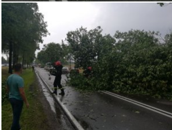
Droga krajowa nr 19 po nawałnicy
