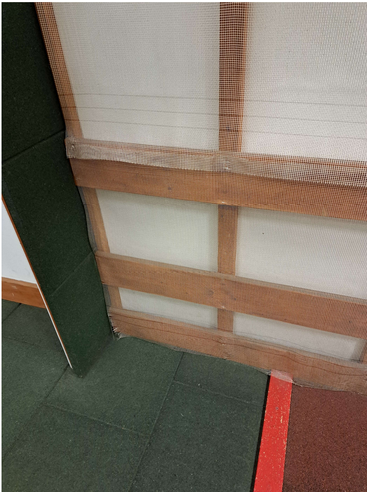
Widok ściany oraz pierwszej przesłony bocznej na długości stanowisk strzeleckich
