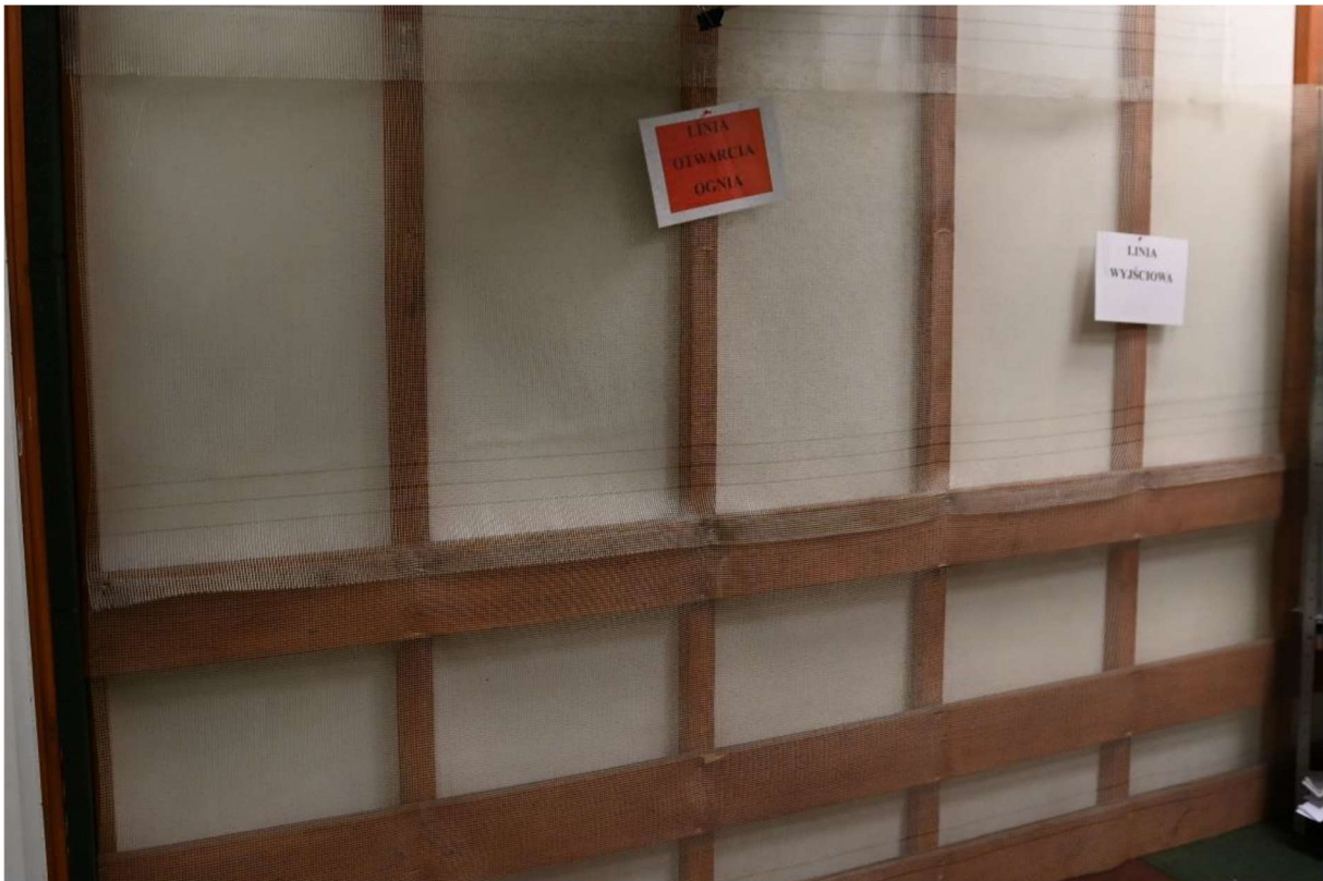
Widok ściany na długości stanowisk strzeleckich
