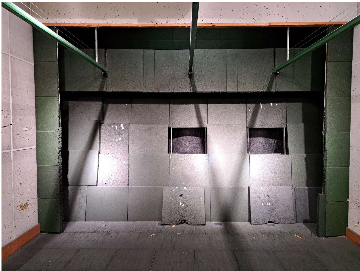
Kulochwyt główny strzelnicy z widoczną ścianą tłumika rykoszetów
