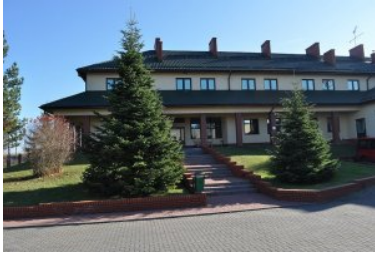
Budynek od frontu.
